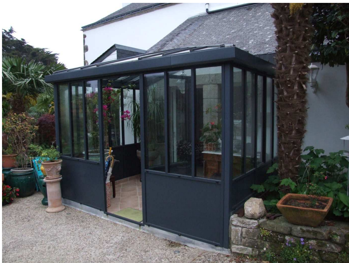
Véranda, objet de l'expertise : vue de la façade nord - nord-ouest.
